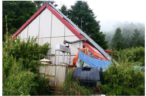
P02.山屋門口雨遮區被供餐協作業業者長期占用作為廚房(外側還搭起防風雨的外帳)。
